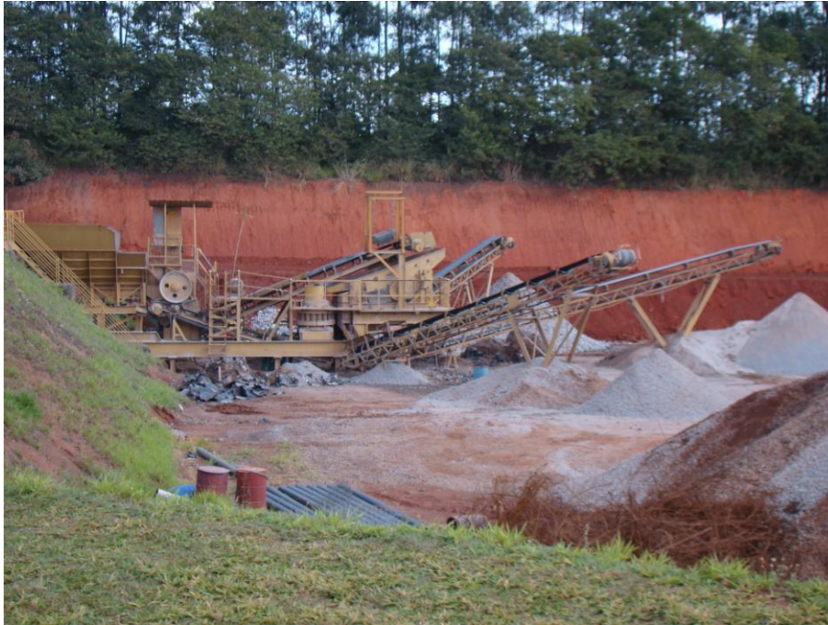
Figura 5. Usina de trituração de resíduos da construção civil
